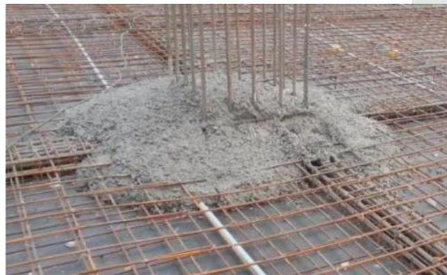
3. 宜先浇筑高强度等级混凝土，后浇筑低强度等级混凝土。
