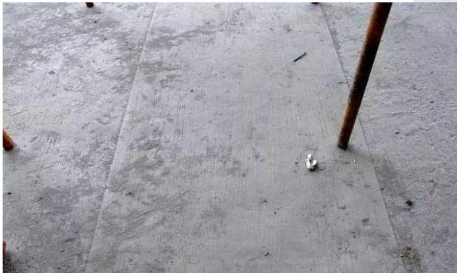
后浇带混凝土强度等级及性能应符合设计要求，当设计无具体要求时，后浇带混凝土强度等级宜比两侧混凝土提高一级，并宜采用减少收缩的技术措施。
